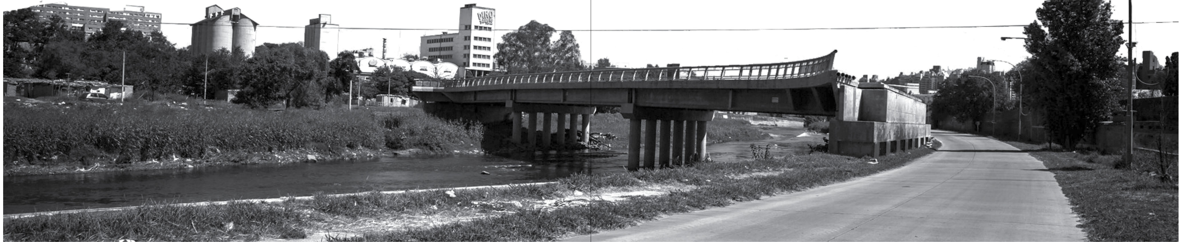
Puente inconcluso "Leticia", Villa La Maternidad.
